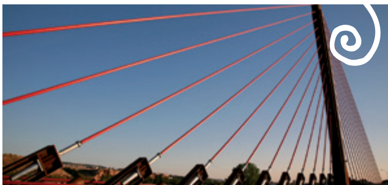
Pont à haubans sur la Ronda Norte de Guadalajara. ▼
